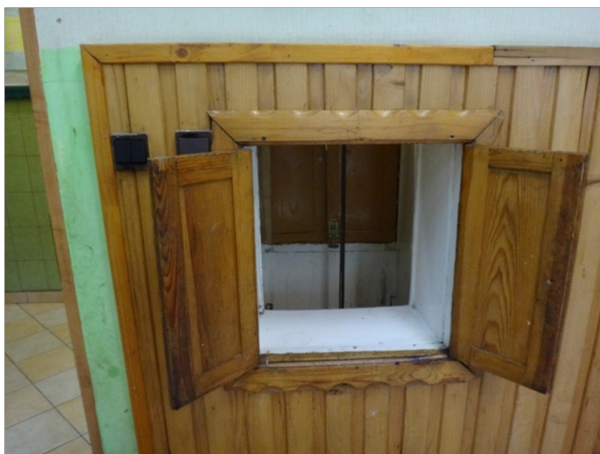
Ilustracja nr 4. Ręczna winda przeznaczona do transportu jedzenia z kuchni do jadalni
